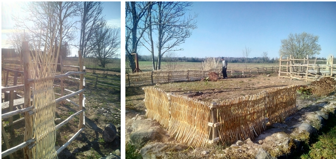
4.attēls. Biedrībā TEEN CHALLENGE LATVIA klūgu žoga izveide (materiāla sagatavošana un žoga izveide)
