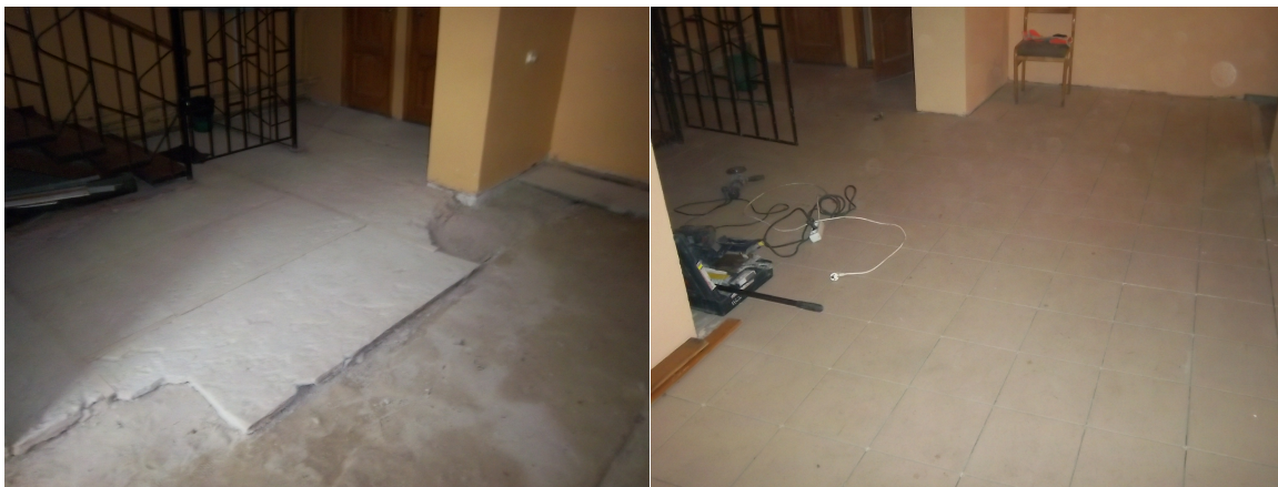
3. attēls. Vecas grīdas demontēšana un jaunas virsmas ieklāšana Augstkalnes pakalpojumu centrā (pirms un pēc)
